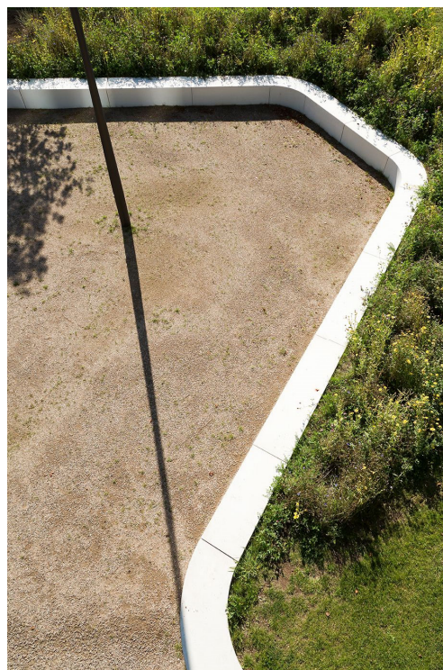
Betonkant og grusbelægning
