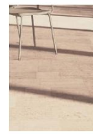
Vinduesplader genbruges som gulv
