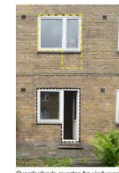
Overskydende mursten fra vindueren- overing anvendes til base
