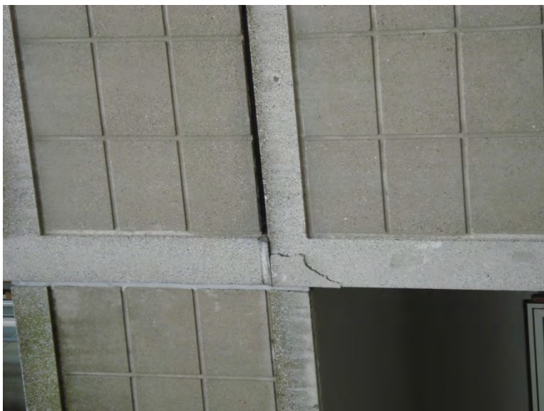
Illustration 11. Eksempel på revne ved lodret facadebånd ved altan.
