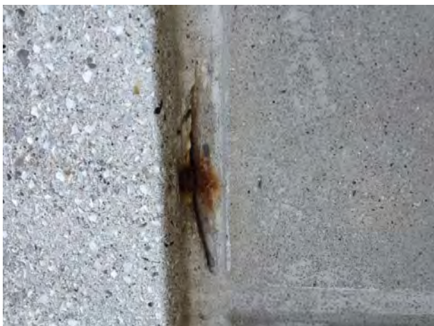
Illustration 15. 24 A, nordsiden, tv. etage 7. Overskåret låsejern.
