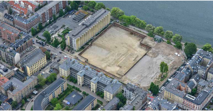
Sådan ser byggepladsen til det nye Sølund ud netop nu.
