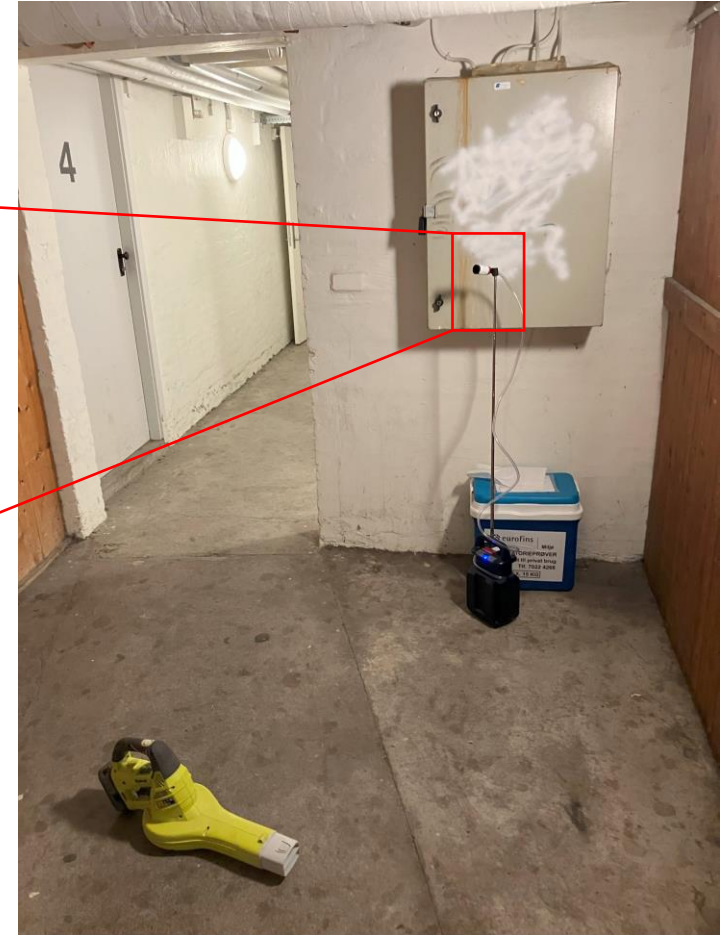
Eksempel på setup for luftprøvetagning - støv hvirvles op og opsamles med pumpe igennem luftkassette med asbestfilter
